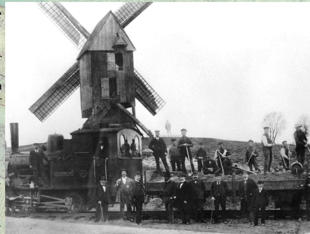
Eine Bildrarität ist das **1897** während der Bauzeit der Steinhuder Meer-Bahn entstandene Foto mit der Lok „Steinhude“ und einem Bauwagen vor der Steinhuder Bockwindmühle.
