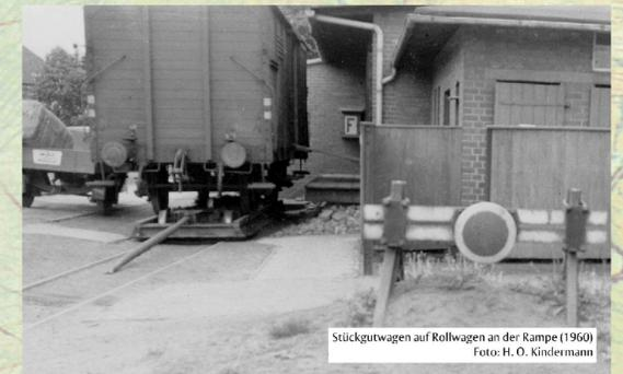
Stückgutwagen auf Rollwagen an der Rampe (1960)
